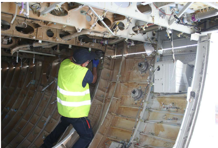
Mitarbeiter von TARMAC bei den Trennarbeiten Foto: Lufthansa Technik
